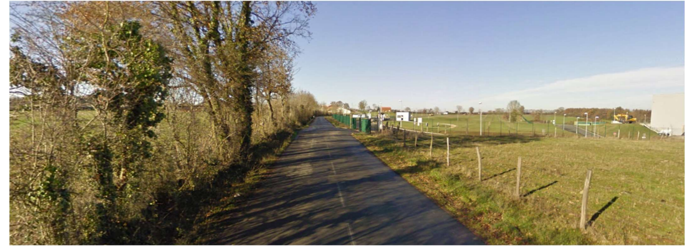
Voirie d'accès à l'entrée de la déchèterie, depuis la RD 157 (source : Google StreetView)
